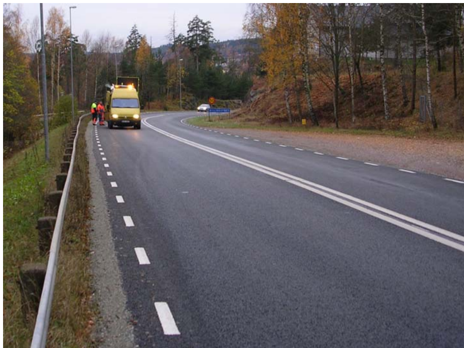
Bild B1.5a Den skadade ytan har täckts med ett tunnskikt.
