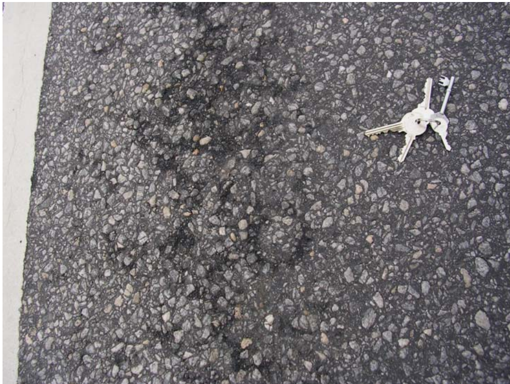
Bild B1.3b visar sprickbildning mot mittskarv i samma sektion som ovan.
