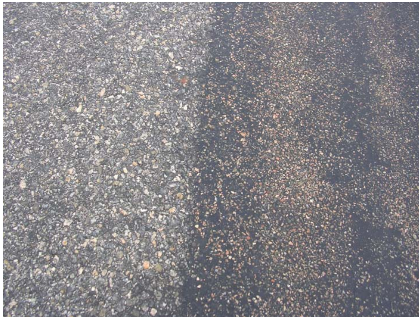
Bild B1.1a-b visar den skadade och delvis lappade ytan på objekt 1.
