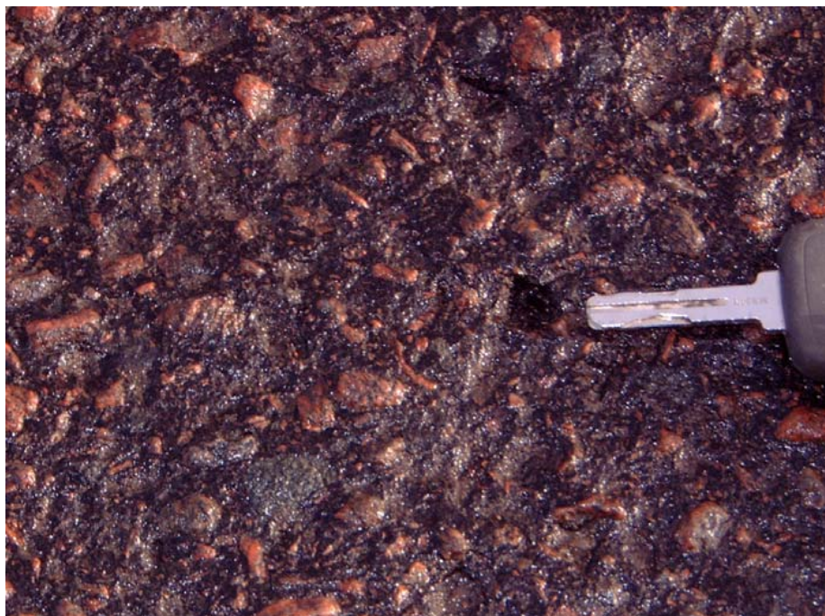
Bild B1.7a-b visar skadad del av objekt 7.
